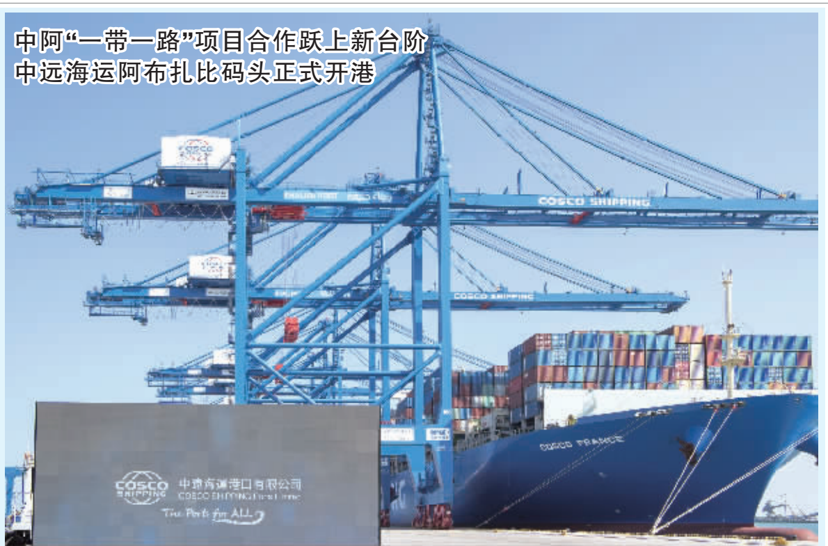
中阿“一带一路”项目合作跃上新台阶 中远海运阿布扎比码头正式开港 由中远海运集团下属中远海运港口有限公司与阿布扎比港务局合资经营的阿布扎比哈里发港二期集装箱码头开港仪式10日举行,标志着中国和阿联酋“一带一路”项目合作跃上新台阶。图为12月10日在阿联酋阿布扎比哈里发港拍摄的中远海运阿布扎比码头现场。 新华社发
