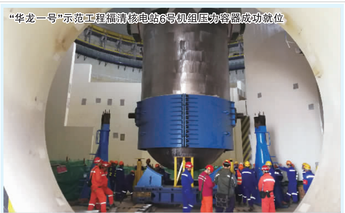
“华龙一号”示范工程福清核电站6号机组压力容器成功就位 12月10日16时8分,具有中国自主知识产权的三代核电技术“华龙一号”示范工程——福建福清核电站6号机组反应堆压力容器成功就位,为后续安装工作的全面展开创造条件。福清核电站位于福建福州福清市三山镇前薛村,规划建设6台百万千瓦级压水堆核电机组,实行一次规划、连续建设,总投资近千亿元人民币,于2008年11月21日开工建设。其中,1-4号机组采用二代改进型成熟核电技术,5号、6号机组是“华龙一号”示范工程。
